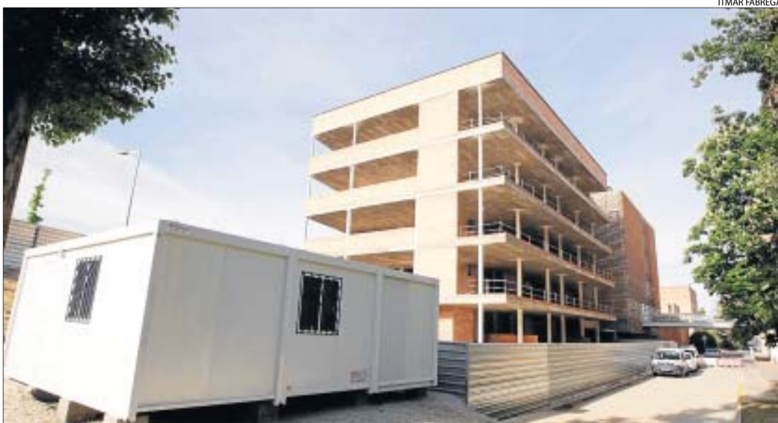
Les obres del segon edifici d'investigació biomèdica es van reiniciar ahir.
